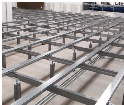
Transformatorrum på Karolinska sjukhuset med förstärkt Iso Floor konstruktion som stödjer 16 transformatorer med en totalvikt på 120 ton.
